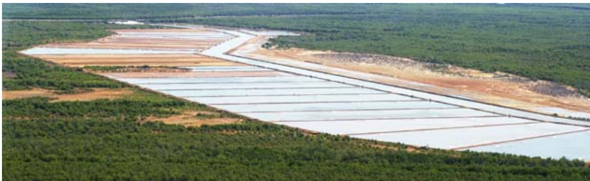
Luftaufnahme der Crevetten-Farm bei Bekopaka
