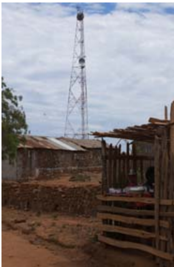
Von Weitem sichtbare Antenne für die Telekommunikation
