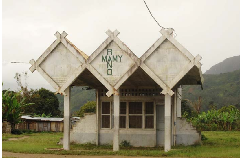
Pumpstation der Wasserversorgung
