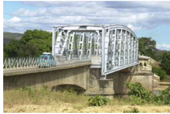
Brücke über den Mananjeba in Ambilobe
