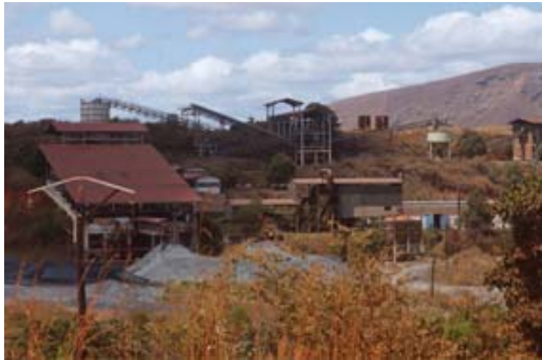
...Aufbereitungs-Anlagen bei den Chromminen in Brieville
