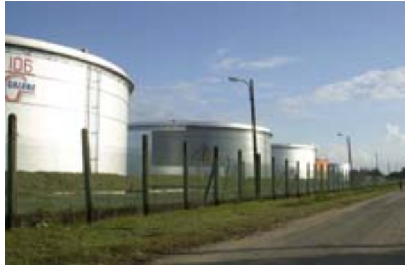
Neues Tanklager der Galana
