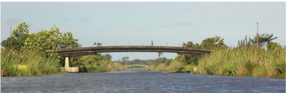
Oben: Alte defekte und unten neuere noch intakte Betonbrücke
