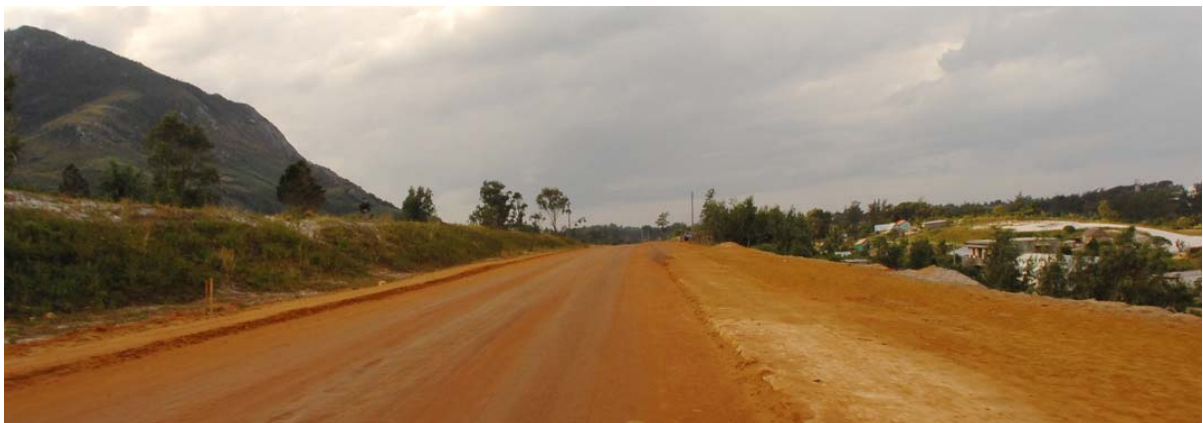
Umfahrungsstrasse erstellt für das Titan-Projekt
