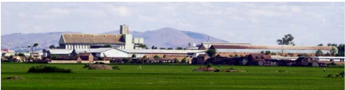
Alte Industriekomplexe in den Reisfeldern in Tana
