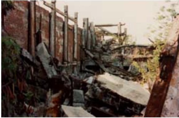
Ehemalige Konserven-Fabrik in Boanamary
