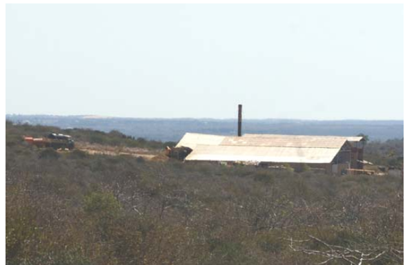
Backsteinfabrik hinter Tuléar
