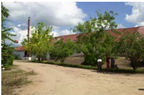
Ylang-Ylang-Destillieranlage in Ambanja
