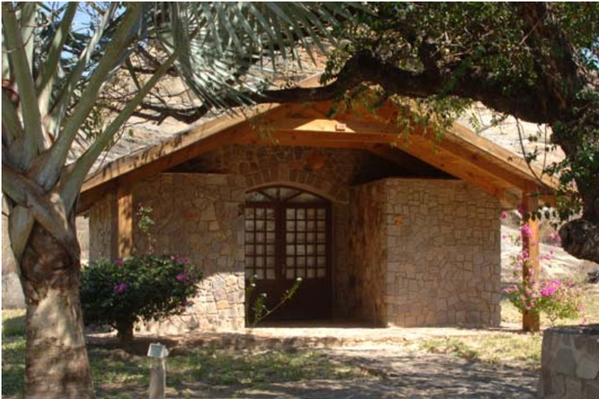
Annexe des Relais mit den Namen „ Rênes d'Isalo “, wo auch Pferdestallungen sind, mit...
