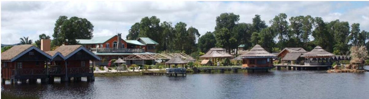
Gesamtansicht der Anlage vom See aus
