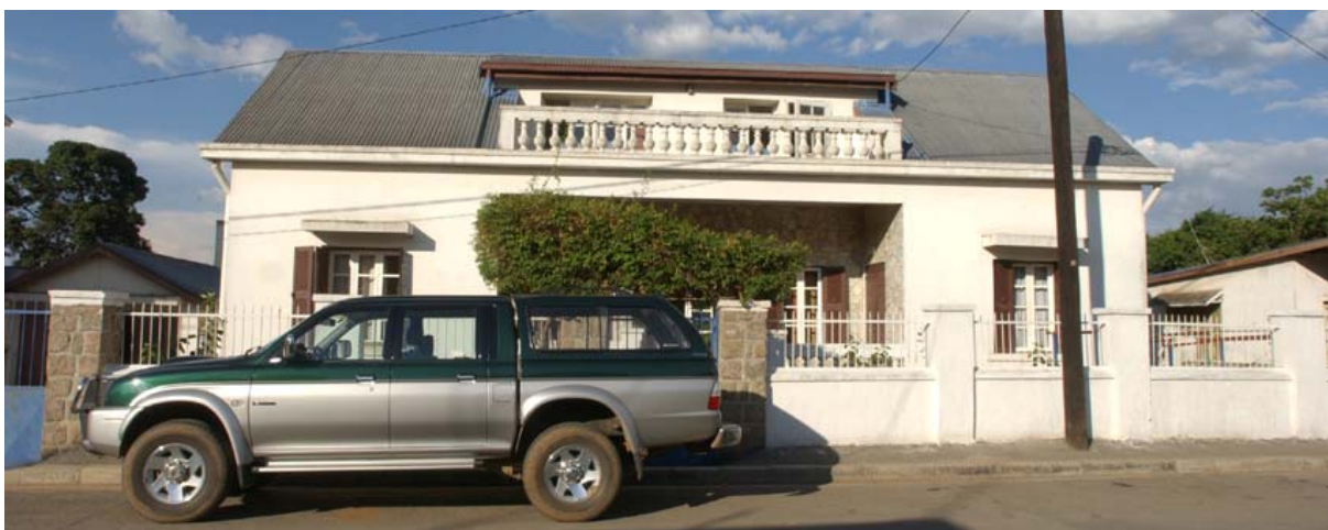
Gesamtansicht von der Strasse her
