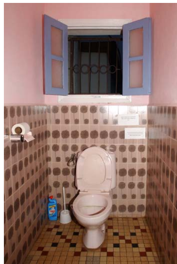
...WC wurden renoviert
