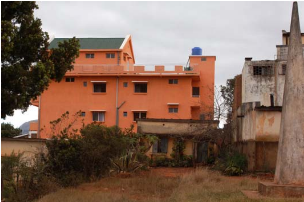
Gebäude des Hotels Tsienimparihy vom Schwimmbad her
