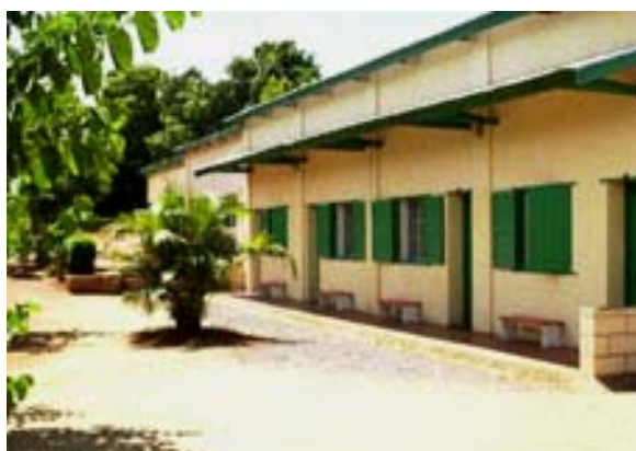
Zimmer ohne warmes Wasser und Dusche
