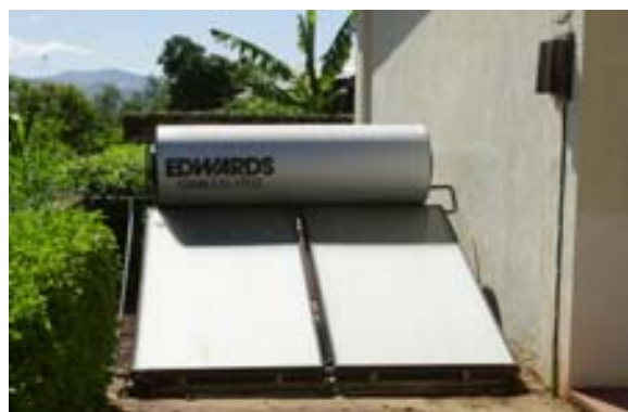
Sonnenkollektoren für das Warmwasser
